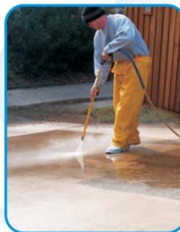
Pisos: Clareamento e impermeabilização
